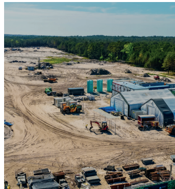
Postęp prac w lokalizacji przyszłej elektrowni jądrowej. Źródło: PEJ
